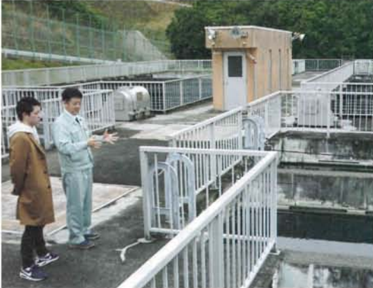
水処理の流れを見学。沈んで池からろ過池へと工程が進むにつれて、水が澄んでいきました
